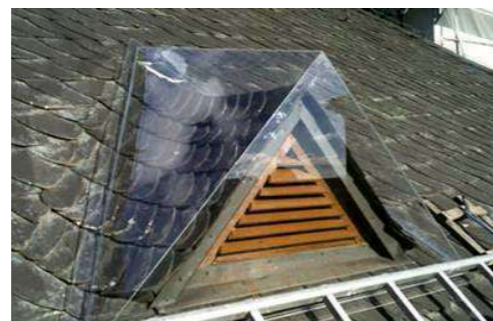
Allemagne: bon exemple: l'air chauffée sur les chiens assis est ventilée dans le nouveau mobilier creux qui sert à donner du confort aux gens qui s'assoient et de la chaleur à l'édifice
