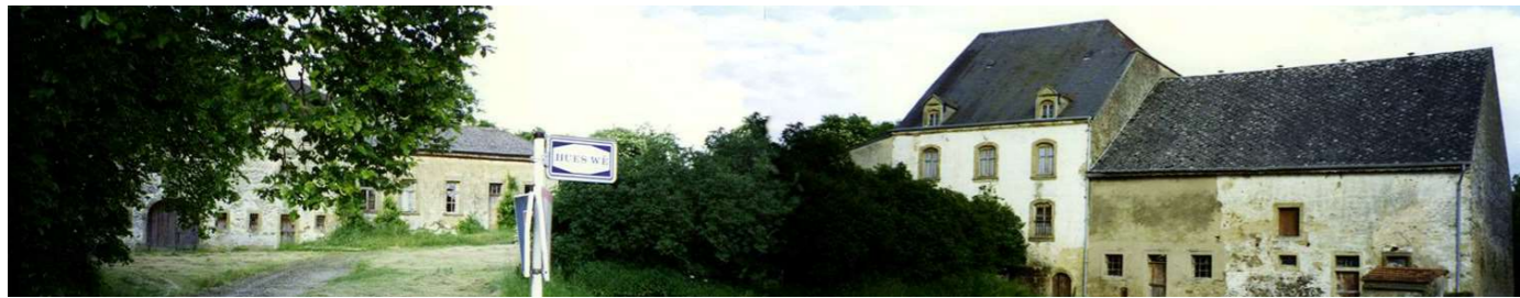
lechternacherhaff à Eschweiler avant restauration
