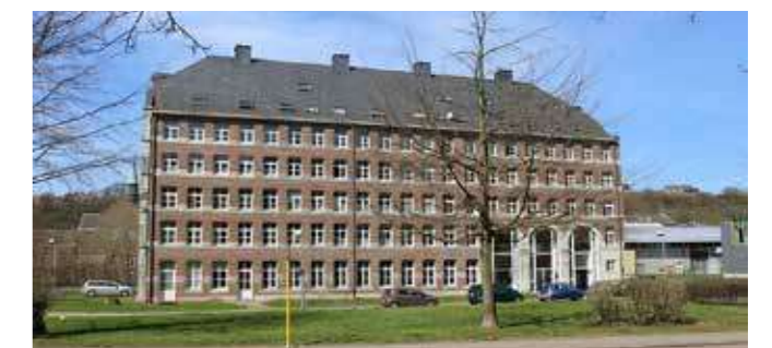
Maison Pelzer, patrimoine industriel transformé en logements, à Verviers (Wallonie)
